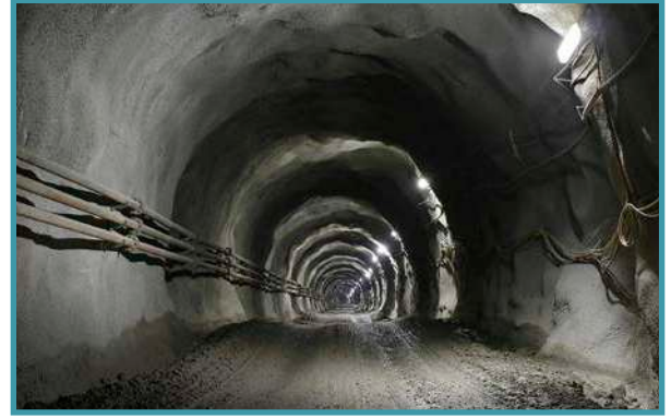
Madenlerde Püskürtme Beton Uygulaması
