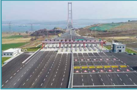
Otoyol Gişe İnşaatlarında
