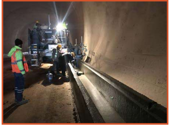
Kablo Kanalı Uygulaması
